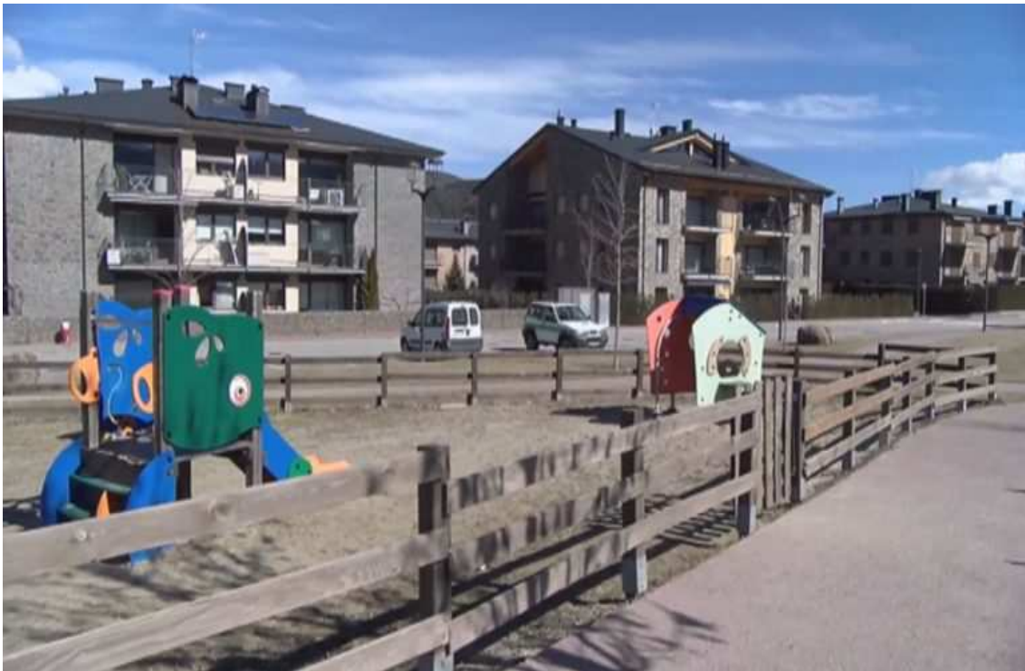
Edificis d'habitatges a Bellver de Cerdanya. / M.F.C.
