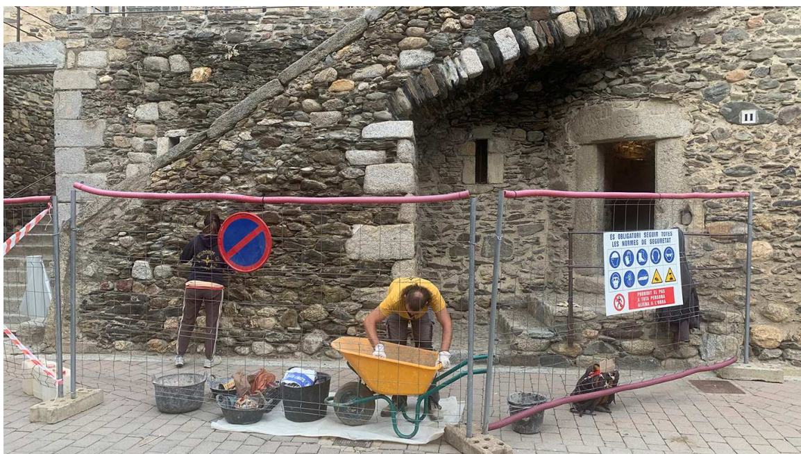
Comencen les obres de restauració i impermeabilització exterior de la Torre Bernat de So, seu de l'Espai Fita 0 / llivia.org
