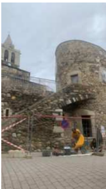
Obres a la torre Bernat de So. / AJ. LLÍVIA
