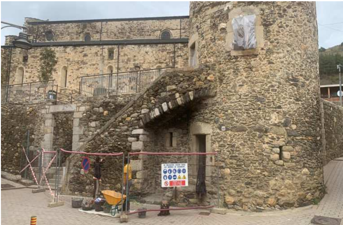
Obres a la torre Bernat de So. / AJ. LLÍVIA
