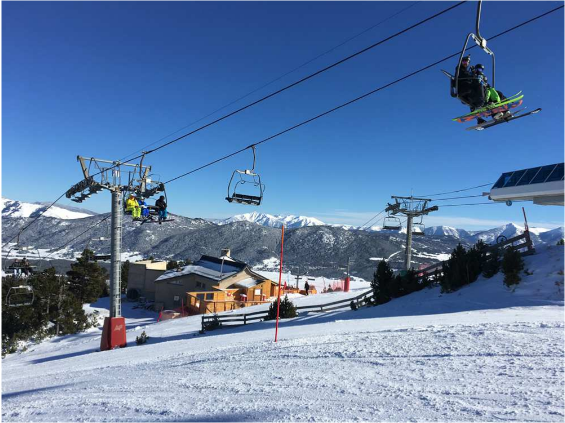
Telecadira Roc d'Aude, una instal·lació de l'any 1999 (Foto: DDLN).
