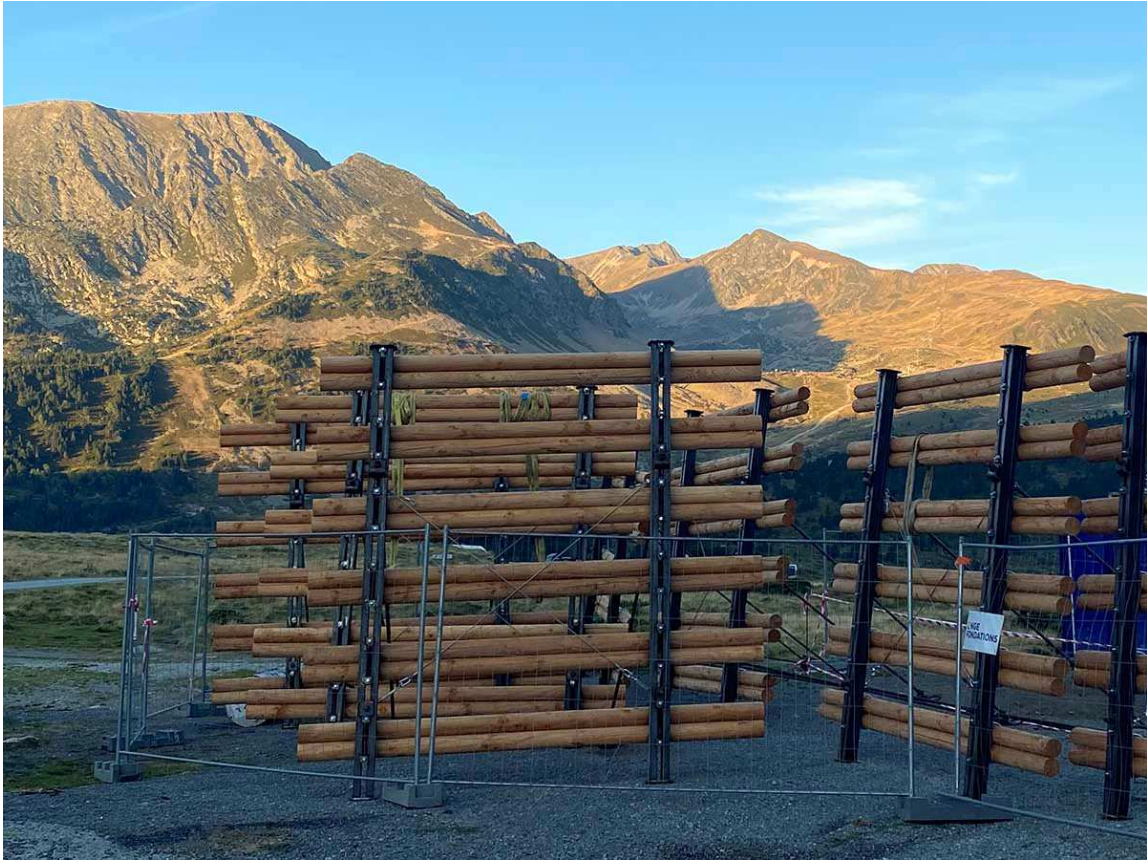
Estructures anti-llau i para-llau a la Coma d'en Garcia (Foto: Diaridelaneu).
