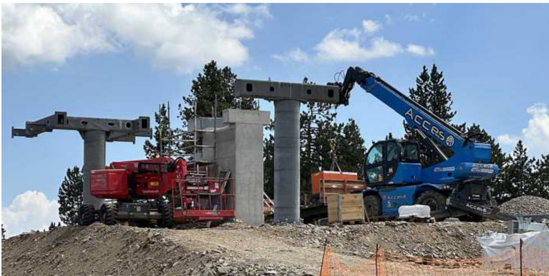
Les primeres pilones de la terminal d'arribada ja estan instal·lades Autor/a: Diaridelaneu
