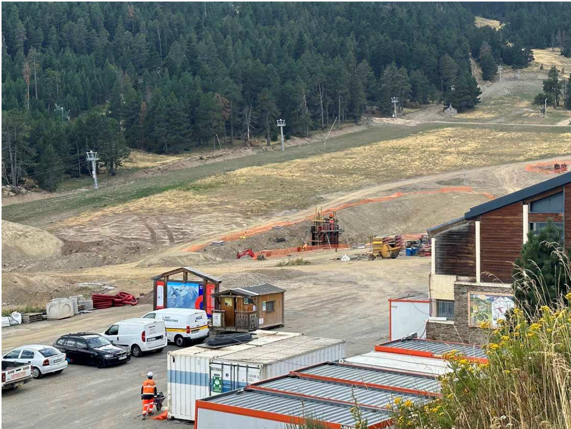
Treballs al peu de pista de Formigueres. Al fons es veuen encara lluent les pilones del teleesquí la Chapelle (Foto: DDLN).
