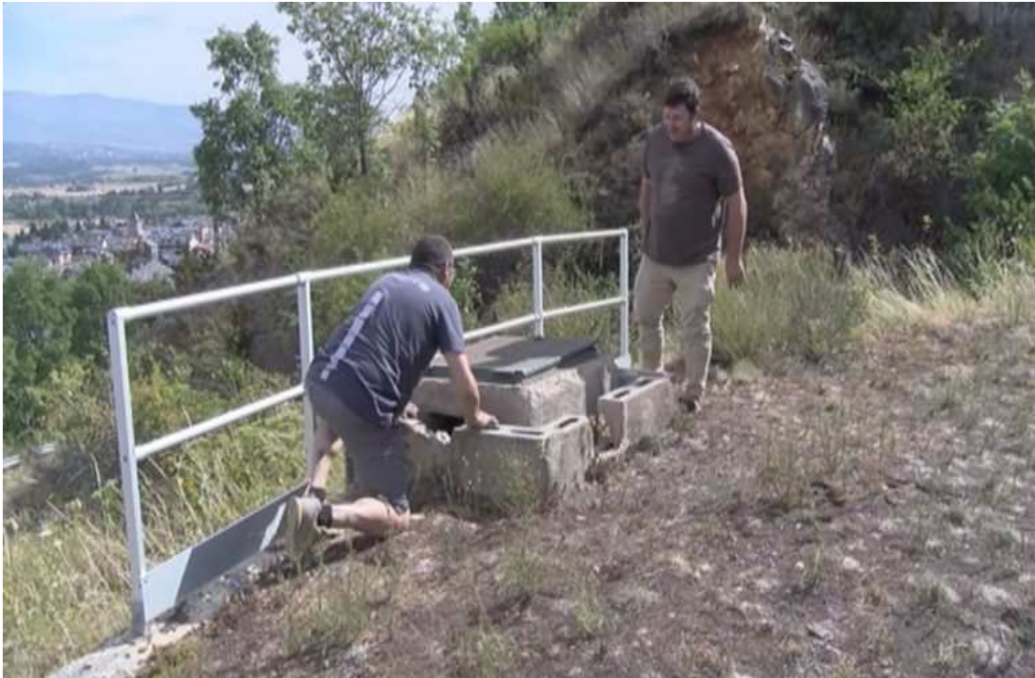
Revisió d'un dels dipòsits d'aigua d'Alp. / M.F.C.
