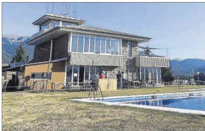
Les instal·lacions renovades de l'aeròdrom de Cerdanya
