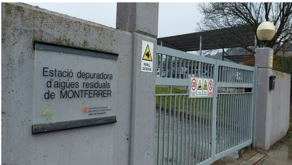
photo_camera Entrada a l'EDAR de Montferrer /Feliu Sirvent viurealspirineus
