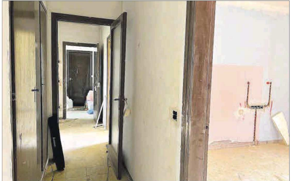
Interior d'un dels pisos de les antigues cases dels mestres d'Alp durant les obres
