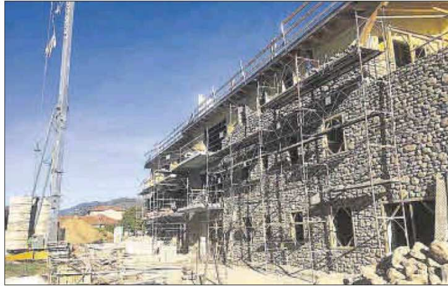
Un bloc de pisos en construcció a Bellver de Cerdanya
