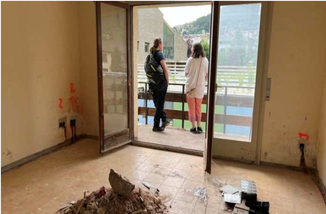
Interior d'un dels pisos que s'habilitaran per a lloguer social
