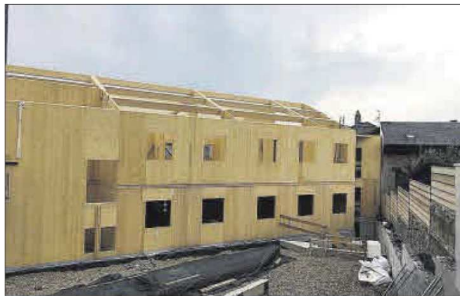
El nou edifici de la residència Sant Roc de Bellver
