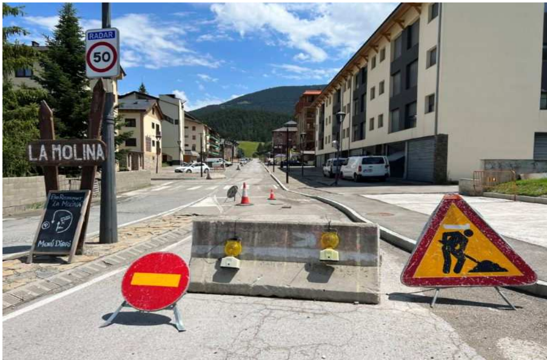
Obres al barri de l'estació de la Molina
