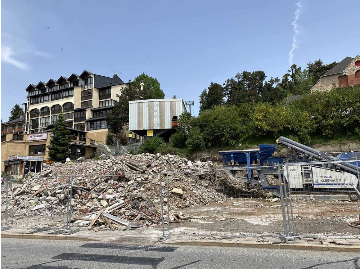
El viejo y vetusto edificio de la estación de salida del telecabina en el mismo pueblo de Font-Romeu, ya es historia. Foto Ivan Sanz Tusell
