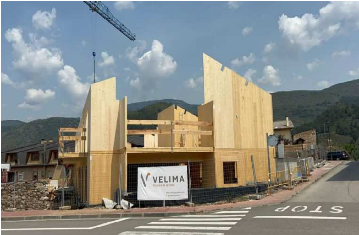
Obres de construcció de l'ampliació de la residència Sant Roc de Bellver de Cerdanya. / M.F.C.
