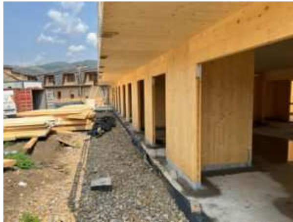
Obres de construcció de l'ampliació de la residència Sant Roc de Bellver de Cerdanya. / M.F.C.
