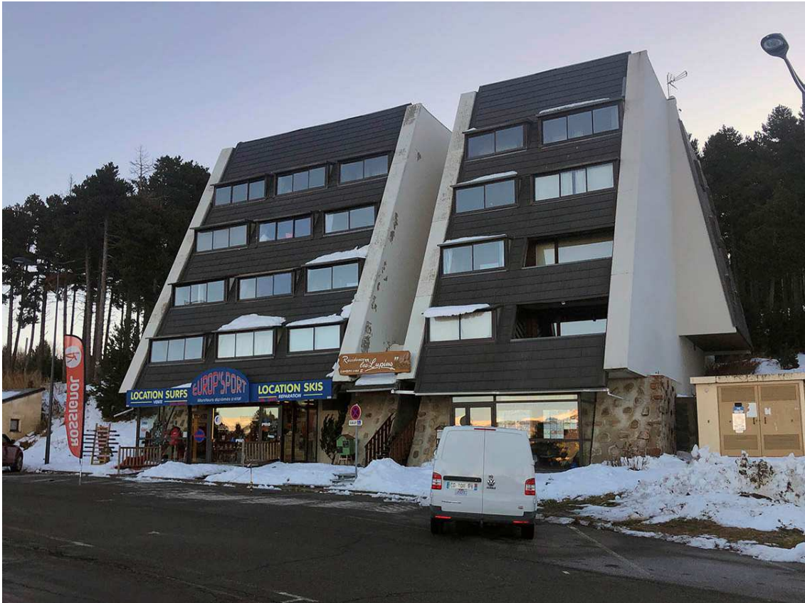
Edifici d'apartaments a Er, a l'Alta Cerdanya (Foto: arxiu DDLN).
