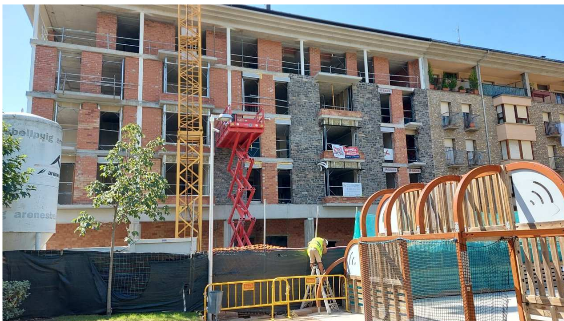
photo_camera Un habitatge en construcció a la Plaça Joan Sansa de la Seu d'Urgell / Feliu Sirvent
