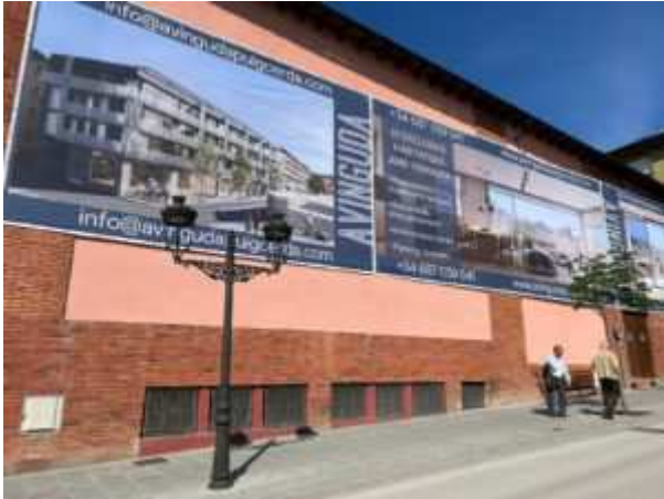
Façana del cinema Avinguda de Puigcerdà, amb l'anunci dels pisos que s'hi faran. / M.F.C.
