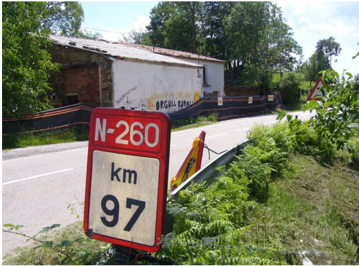
Comencen les obres de reparació del ferm a la carretera N-260a, entre Ripoll i Vallfogona de Ripollès.
