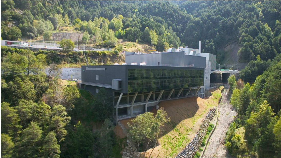
Centre de Tractament de Residus d'Andorra, a la carretera de la Comella / CTR
