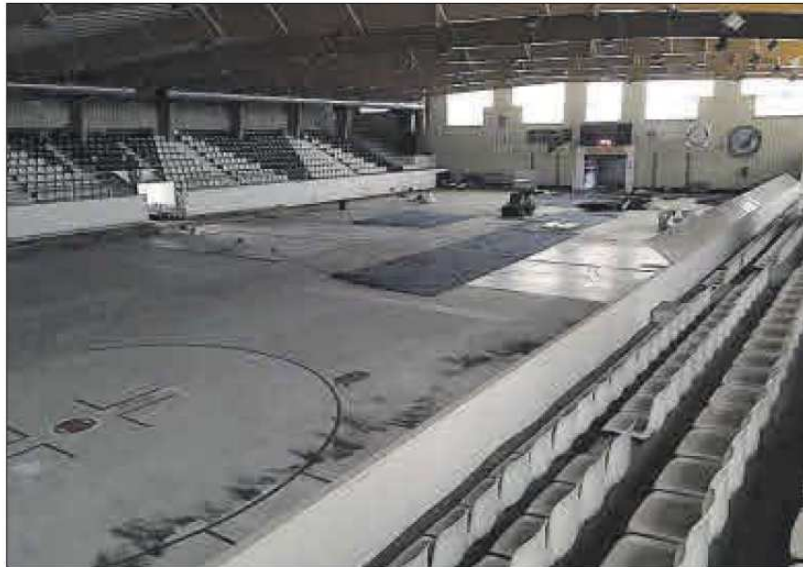
Les obres de renovació de la tanca de la pista de gel
