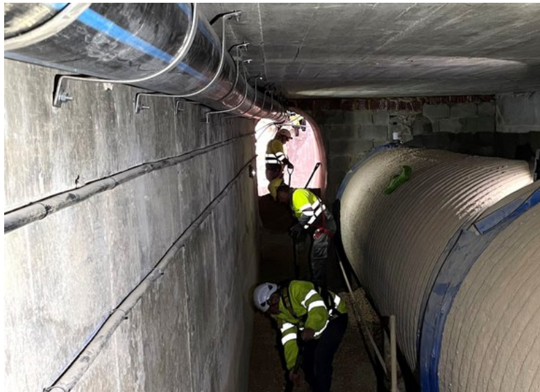
Operaris treballant en una canonada ACN.
