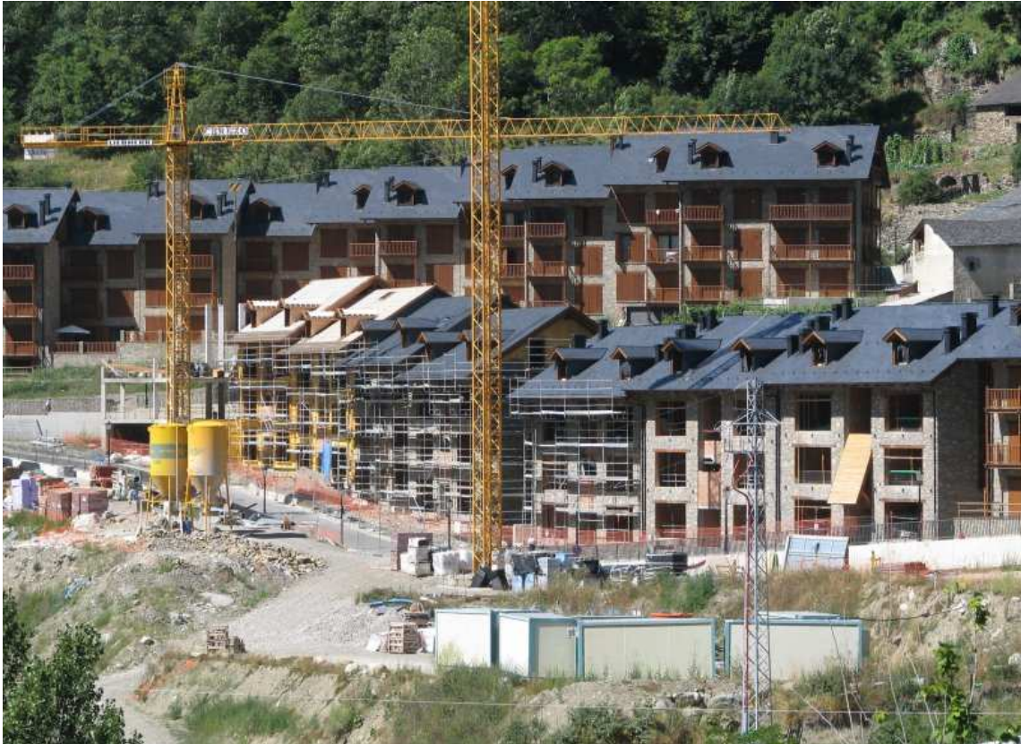
Construcció de pisos aturada a Espui (Imatge d'arxiu - ACN).
