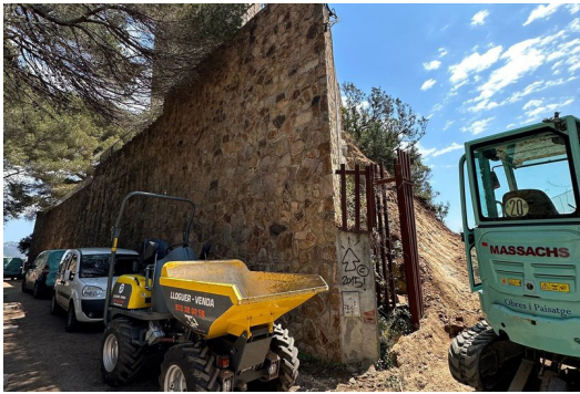
S'inicien les obres del tram que ha de connectar la platja de Lloret i Fenals AJUNTAMENT DE LLORET.
