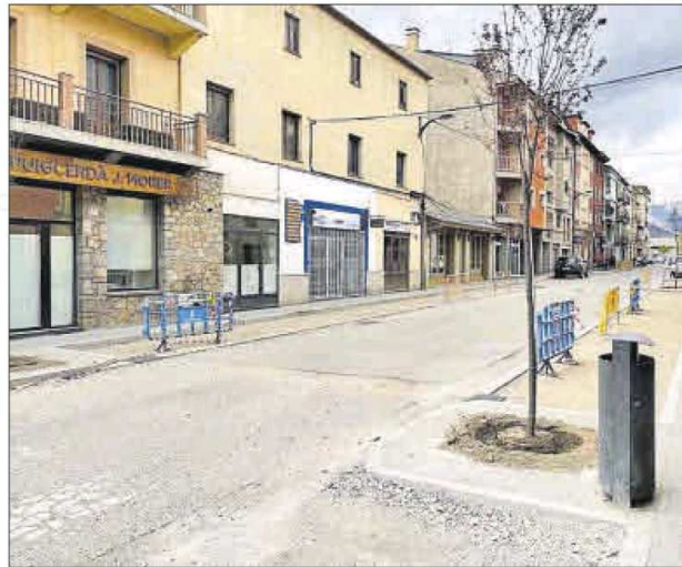
L'avinguda dels Pirineus amb arbres abans de l'asfaltatge
