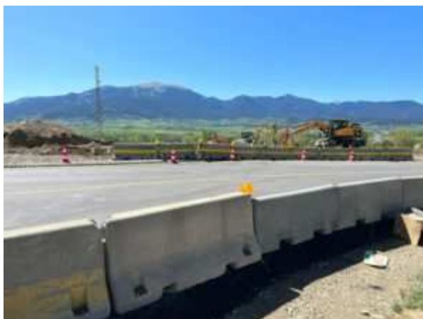
Construcció de la rotonda de Ger. / M.F.C.
