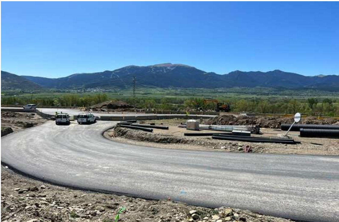
Construcció de la rotonda de Ger. / M.F.C.
