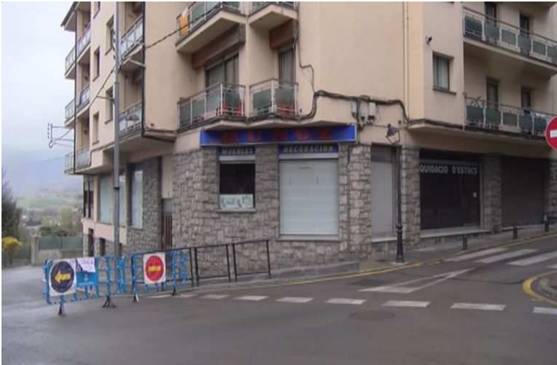
Exterior del local que acollirà Serveis Socials de Cerdanya. / M.F.C.
