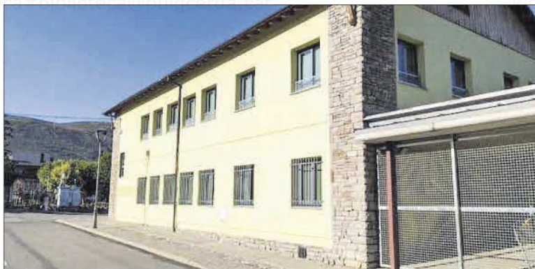
L'edifici de l'escola Mare de Déu de Talló de Bellver de Cerdanya
