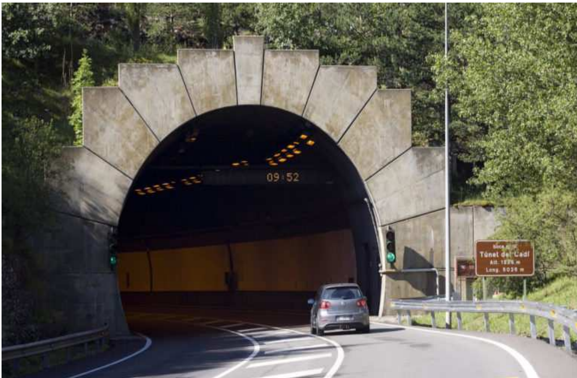
El Túnel del Cadí. / T.B.C.
