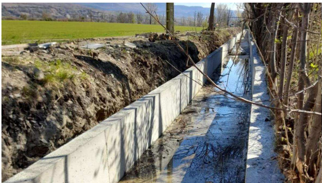
Un dels trams en obres del canal de Ger Arxiu
