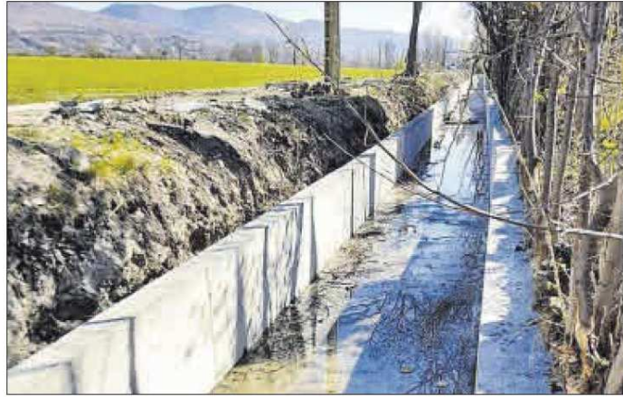
Un dels trams en obres del canal de Ger
