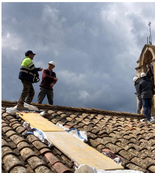
Els operaris encarregats de despenjar la campana de les tempestes, fent els treballs A.T.
