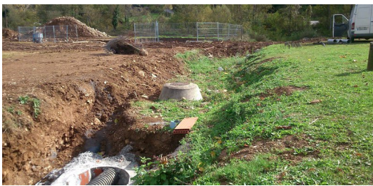
Les canonades per a la depuradora d'Oix, en una imatge del 2016. R. E.
