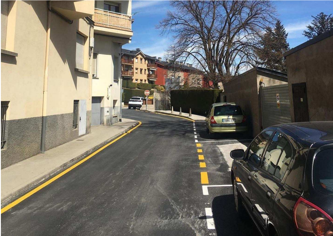
Puigcerdà executa les obres de pavimentació dels carrers Junoy i Fites i de la plaça del Triangle / puigcerda.cat
