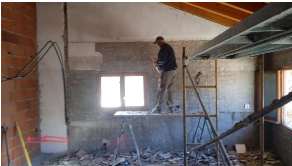
Operari treballant en les obres de l'ajuntament de Prats
