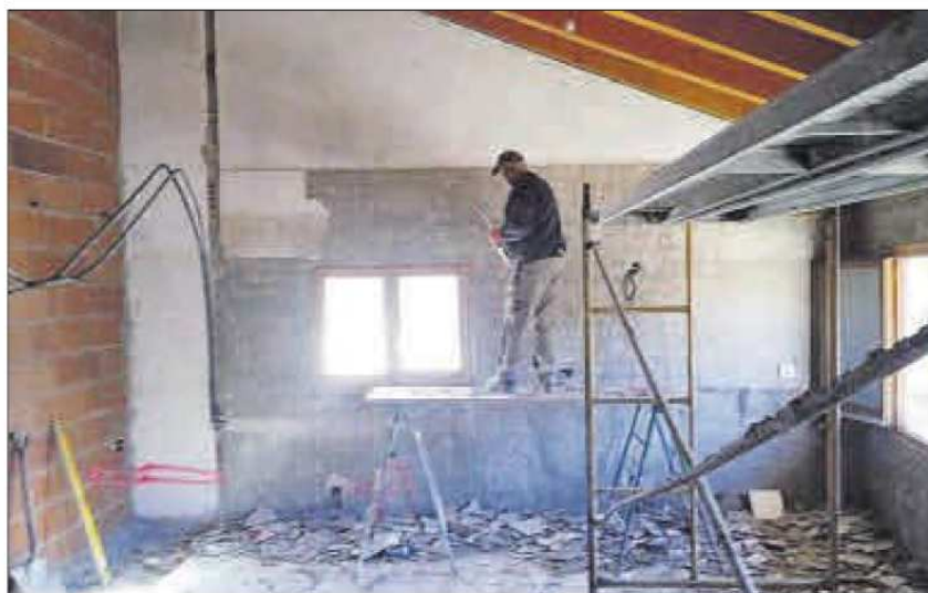
Un operari a les obres de reforma de l'ajuntament
