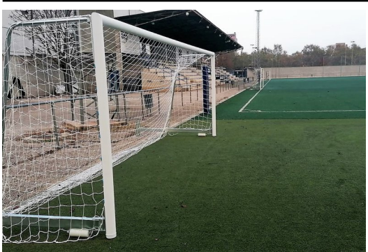
El camp de futbol El Pla, on s'ubicarà la noca central de biomassa AJUNTAMENT DE SALT.
