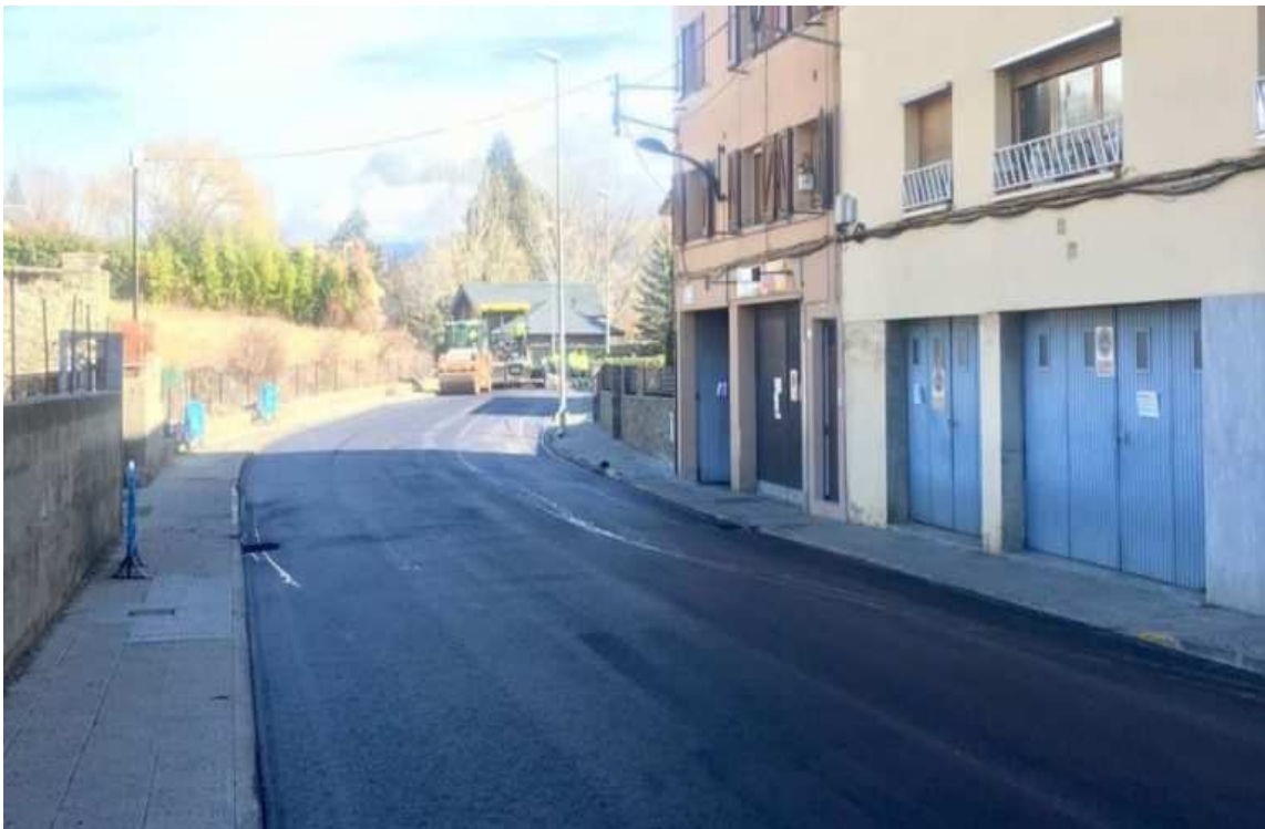
Obres al carrer Font d'en Lleres. / AJ. PUIGCERDÀ
