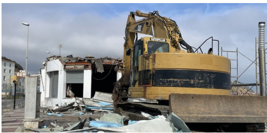
Els treballs d'enderroc, que han començat aquesta setmana. AJUNTAMENT DE BLANES.
