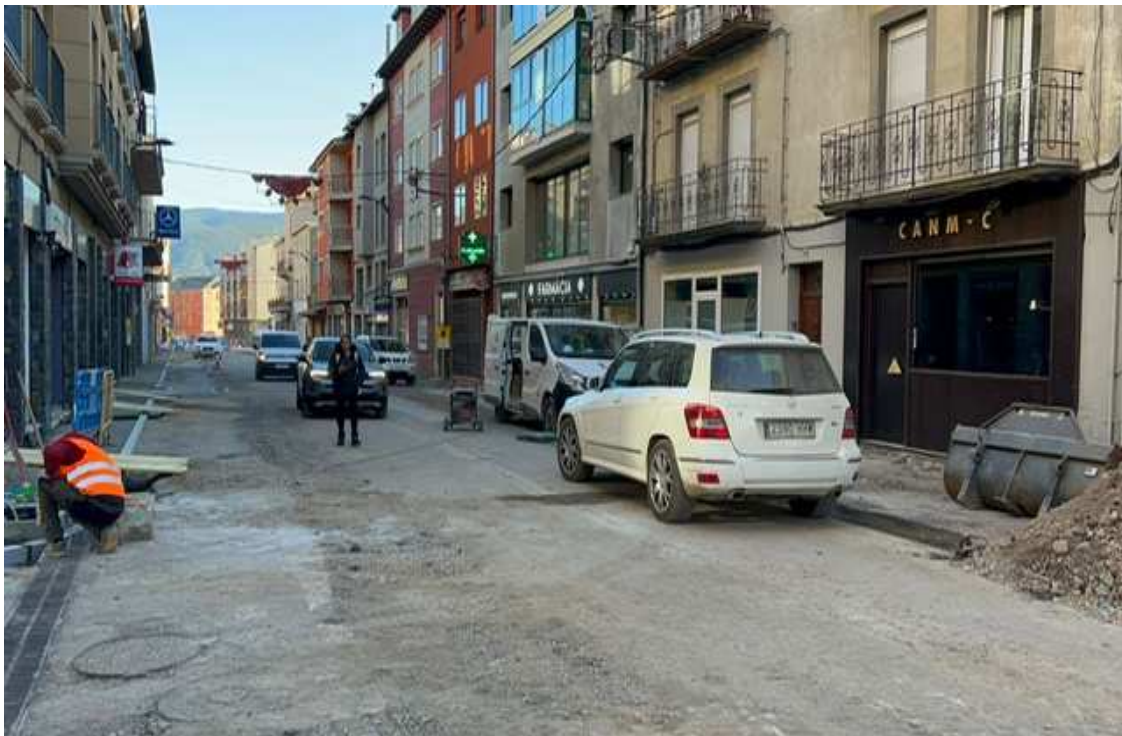
Obres a l'avinguda Pirineus de Puigcerdà. / M.F.C.
