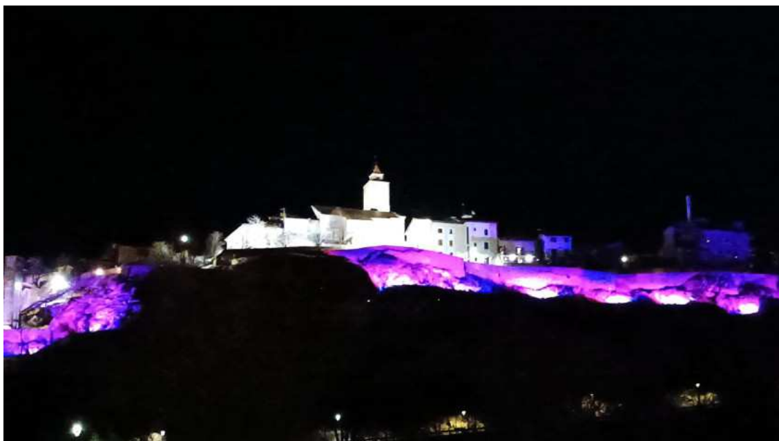
Nou sistema d'enllumenat de la muralla de Bellver de Cerdanya
