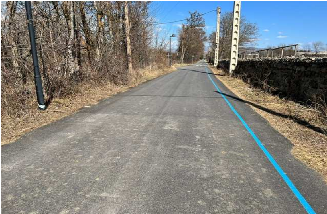
Obres a la carretera de Ventajola. / M.F.C.
