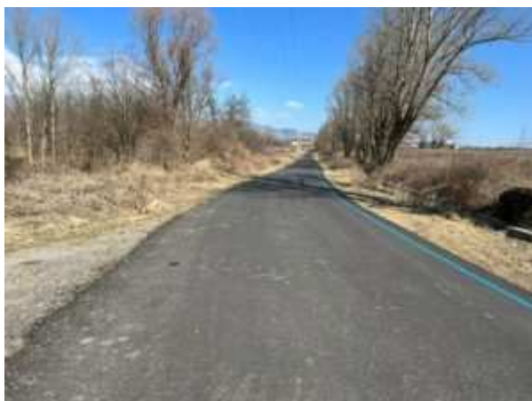
Obres a la carretera de Ventajola. / M.F.C.
