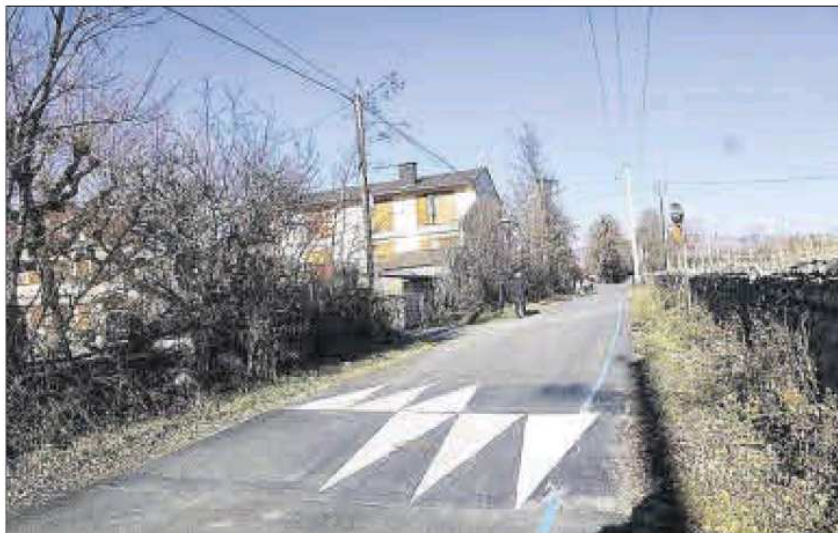
La carretera de Ventajola amb el ferm renovat
