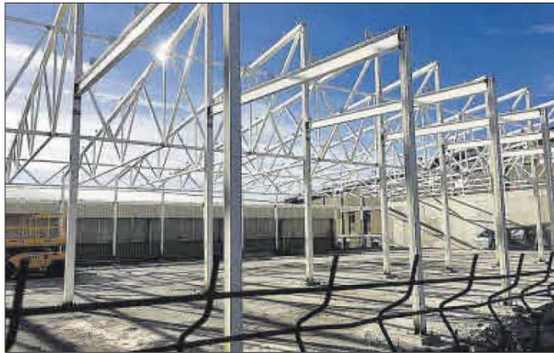
L'estructura superior del nou Centre Cívic ja aixecada
