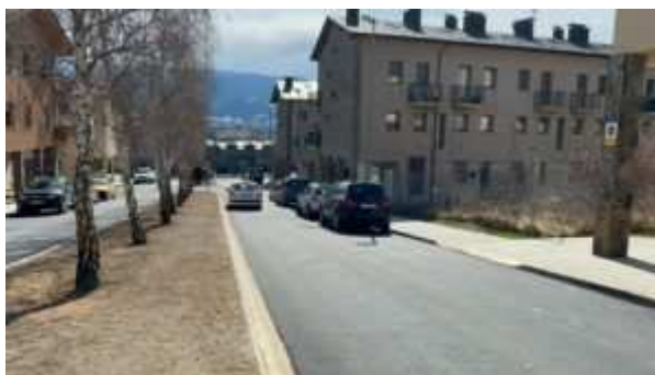
Un dels carrers del barri de l'Incasòl de Puigcerdà on s'ha renovat el paviment. / M.F.C.
