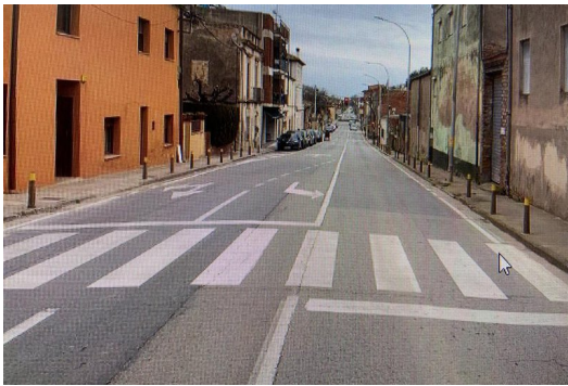
Verges pot afrontar la millora del tram urbà de la carretera GI-634.
