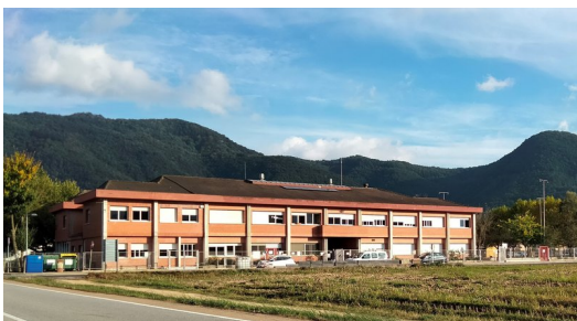
Les plaques fotovoltaïques que hi ha instal·lades a la coberta de l'escola Verntallat de la Vall d'en Bas J.C.
