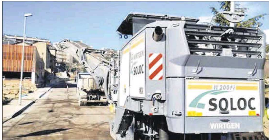
Màquines i operaris treballant aquesta setmana en les obres dels carrers de l'Incasòl
