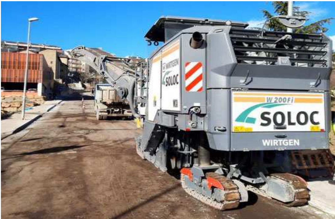
Tasques de pavimentació al barri de l'Incasòl. / AJ. PUIGCERDÀ
